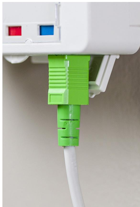
Avec l'élargissement de l'accès internet Très Haut Débit (THD), la technologie Fiber To The Home (FTTH) connaît une ascension fulgurante. Celle-ci consiste à déployer des réseaux en fibre optique depuis le nœud de raccordement optique jusque dans les logements des abonnés ou dans les locaux à usage professionnel, dans les entreprises ou les administrations (FTTB/FTTO).
