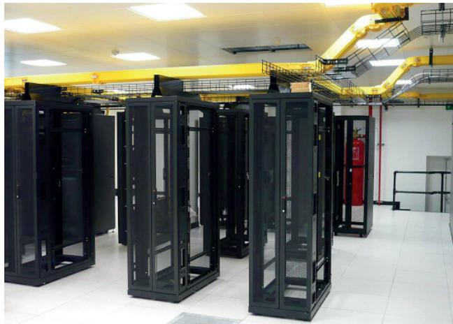
Installation typique de système de management de cuivre et fibre en hauteur avec des fixations customisées sur le toit des baies
