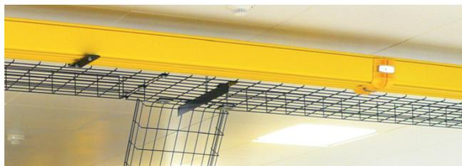
Installation typique d'un cheminement suspendu avec des supports fixés au plafond
