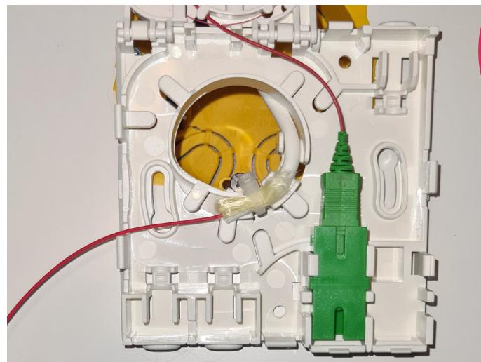
Serrer les vis afin de fixer la PTO sur le boîtier d'encastrement.
