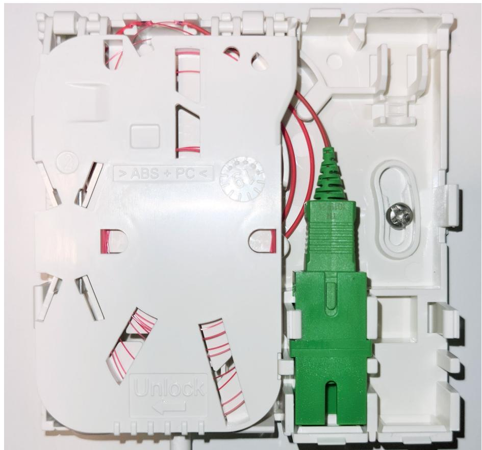
Fermer le capot et coller l'étiquette d'identification client sur ce dernier.
