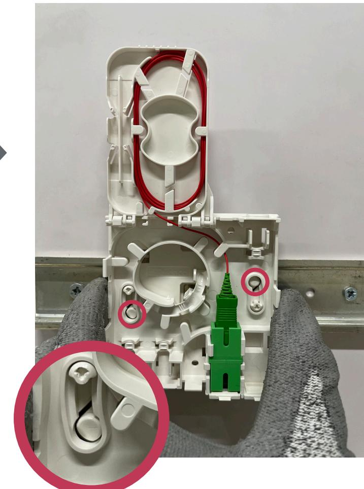
L'installation sur rail DIN est terminée. Poursuivre le raccordement optique de l'abonné.
