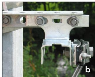
La semelle équerre Telenco® 5/39 est utilisée par paire pour la fixation des traverses sur les appuis rectangulaires. Elles se cerclent sur le poteau à l'aide de deux feuillards inox 20 x 0,7 mm équipés de boucles 20mm. La traverse est fixée sur les semelles équerres avec deux boulons d'assemblage 1/12 (a).
