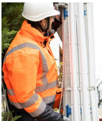
Le T-Pass TED est un outil non-conducteur innovant conçu pour faciliter et sécuriser l'installation de feuillard sur les poteaux ENEDIS avec remontée de câble énergie. Sa forme a été étudiée pour se glisser sous les goulottes, mêmes serrées sur les poteaux, sans risque d'endommager les câbles présents.
