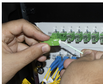
Nettoyage d'une férule 2.5 mm SC/ST/FC
