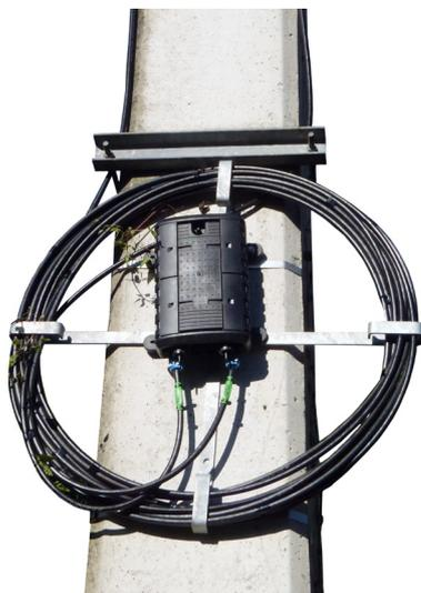
Le déploiement des réseaux de fibre optique aériens et souterrains nécessite une gestion rigoureuse des sur-longueurs de câbles aux points d'épissures situés sur les poteaux électriques ou dans les chambres. Telenco® propose deux modèles différents de croix de lovage pour câbles à fibre optique permettant de déployer des réseaux de télécommunications optiques aériens ou souterrains fiables.
