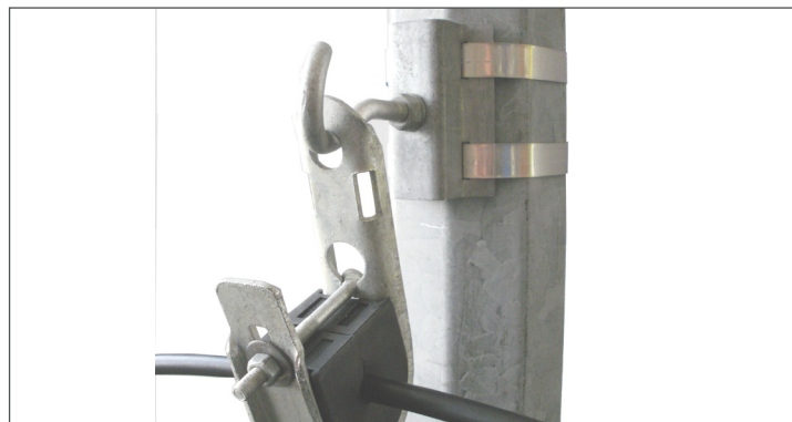
Fixation sur console et queue de cochon
