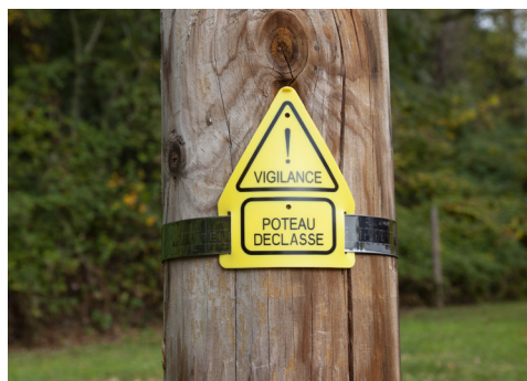
Par une bande de feuillard jusqu'à 20 mm de largeur
