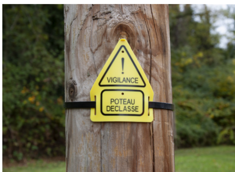
Par un collier de serrage jusqu'à 20 mm de largeur
