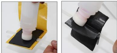
**b)** Séparer les câbles afin de faciliter l'installation du croisillon et lubrifier les zones de contact.
